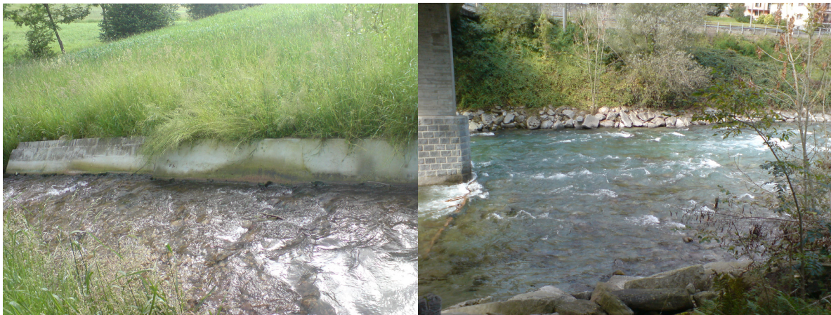
Abbildung 2.10: Beispiele zweier Verbauungsarten. Links der Ryckenbach (LU) mit einer Betonverbauung und rechts die Moesa (TI) mit einem typischen Blockwurf.
